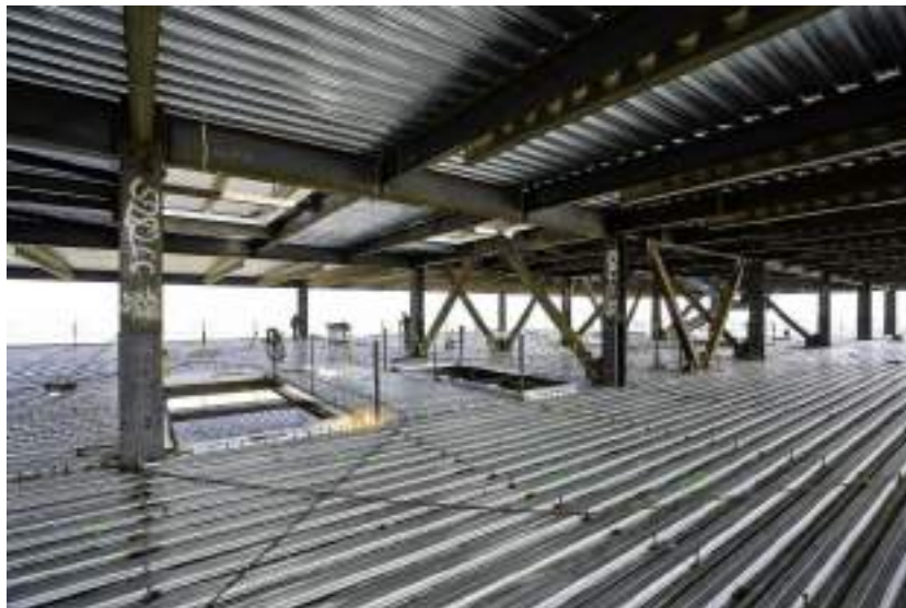
Gráfico 47. Construcción losa entrepiso con losacero galvanizado.
