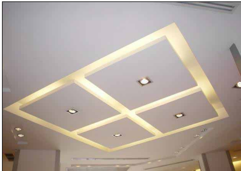
Figura 27:Cielo Raso de Yeso (2017)
