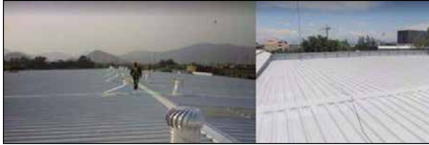
Figura 32: Cubierta de FibroMat(2017)
