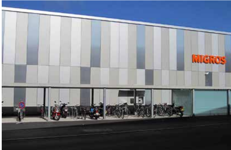
Figura 32. Revestimiento en fachada con Alecubond. Fuente: http://img.archiexpo.es/images_ae/photo-g/1616-9450956.jpg (2018)
