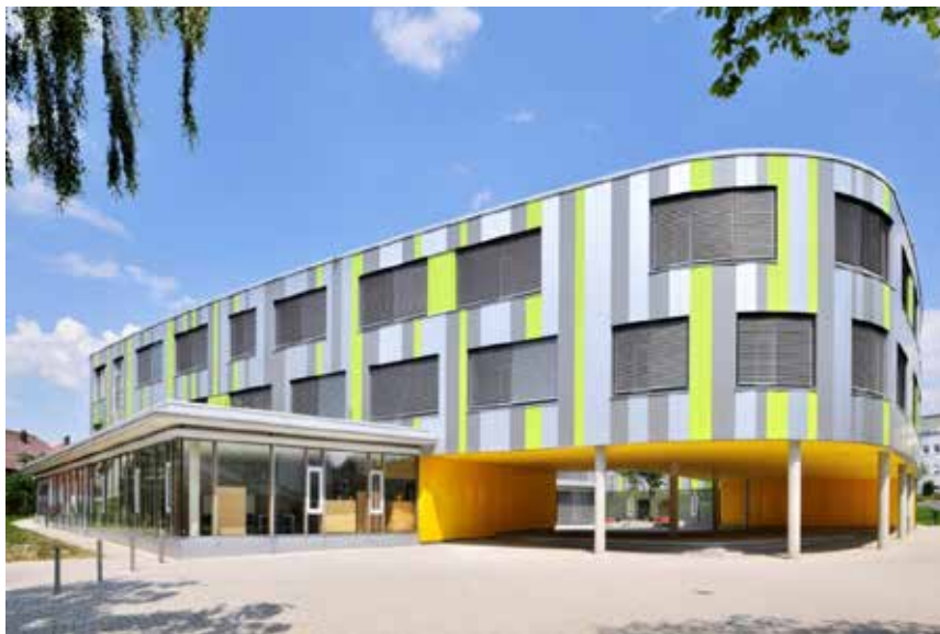
Figura 1 Vista externa de la Escuela Laupheim, fuente:
