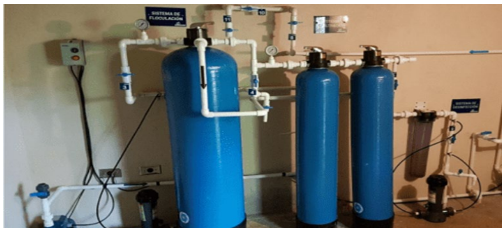
Figura 23. Sistema de tratamiento compacto propuesto (fisicoquímico)
