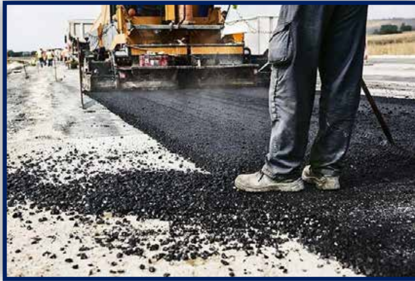
Figura 1. Realización de bacheo
