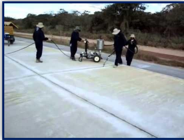
Figura 14. Mantenimiento de juntas.
