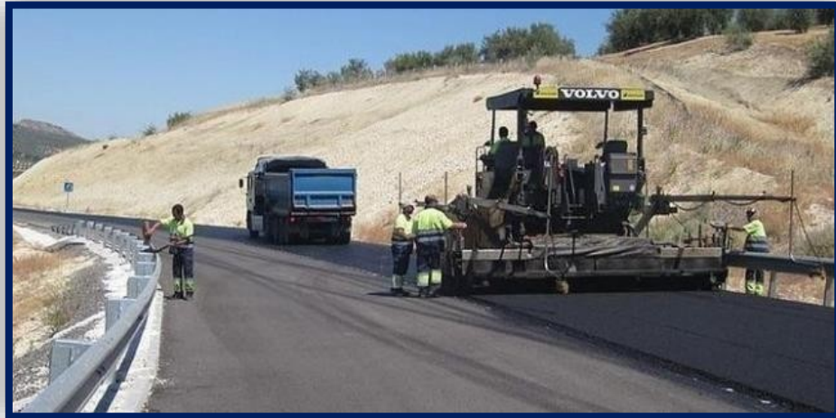
Figura 9. nivelación asfáltica con motoniveladora
