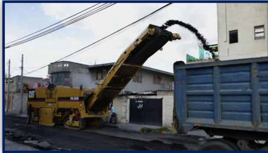
Figura 11. Fresadora en funcionamiento.
