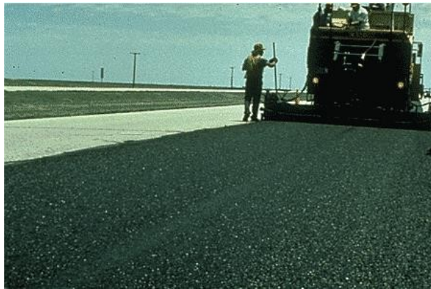
Figura 49. Pavimento Slurry Seal.
