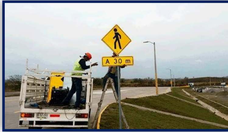
Figura 4. Restauración de la señalización.
