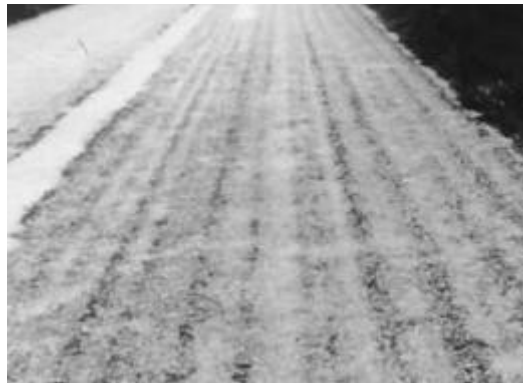
Figura 15. Desintegraciones por Estrías Longitudinales
