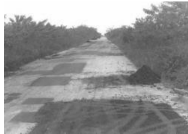
Figura 21 Bacheo y Reparaciones.
