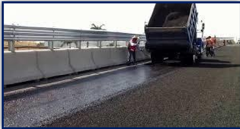
Figura 10. Sellado asfáltico.
