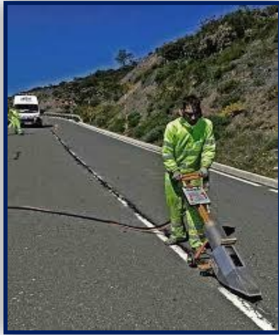
Figura 2. Sellado de fisuras
