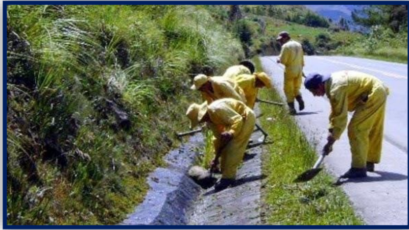
Figura 6. Limpieza de cunetas.
