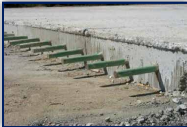
Figura 16. Pasadores en pavimento rígido.
