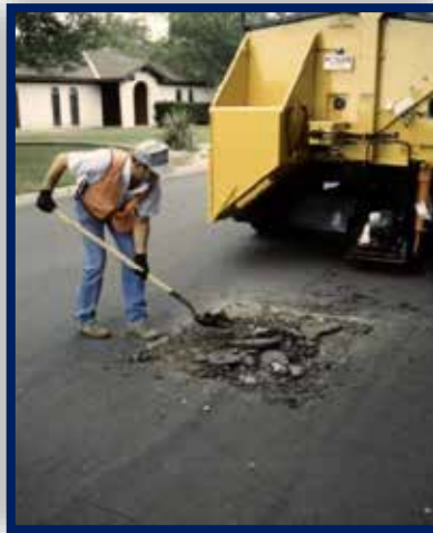
Figura 8. Realización de bacheo correctivo
