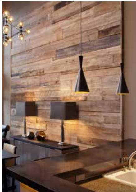
Figura 9: Revestimiento en madera reciclada. Fuente: Pinterest (2016)
