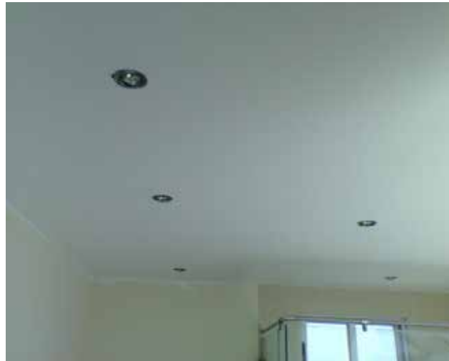
Figura 14: Cielo raso en plafón. Fuente: Google (2016)
