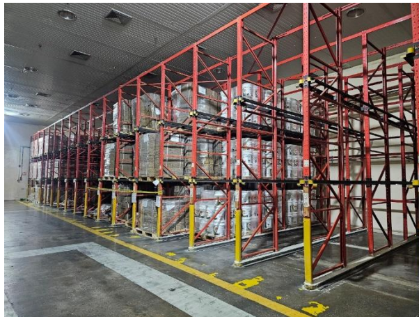
Figura 12: Almacén temporal de producto retenido (antiguo cuarto frío) Fuente: Departamento de Logística de Cargill de Venezuela S.R.L (2024)
