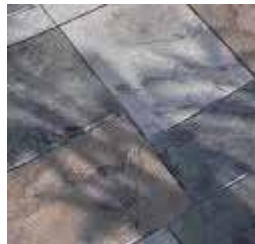
Figura 27. Revestimientos de Paredes de Salas Sanitarias.
