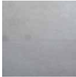
Figura 26. Revestimientos de Paredes de Salas Sanitarias.
