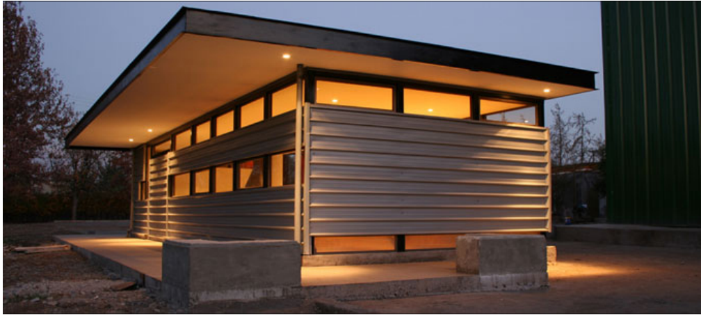
Figura 8: Comedor para Trabajadores. Mostazal, Chile. Fuente: http://en.wikiarquitectura.com (2009)
