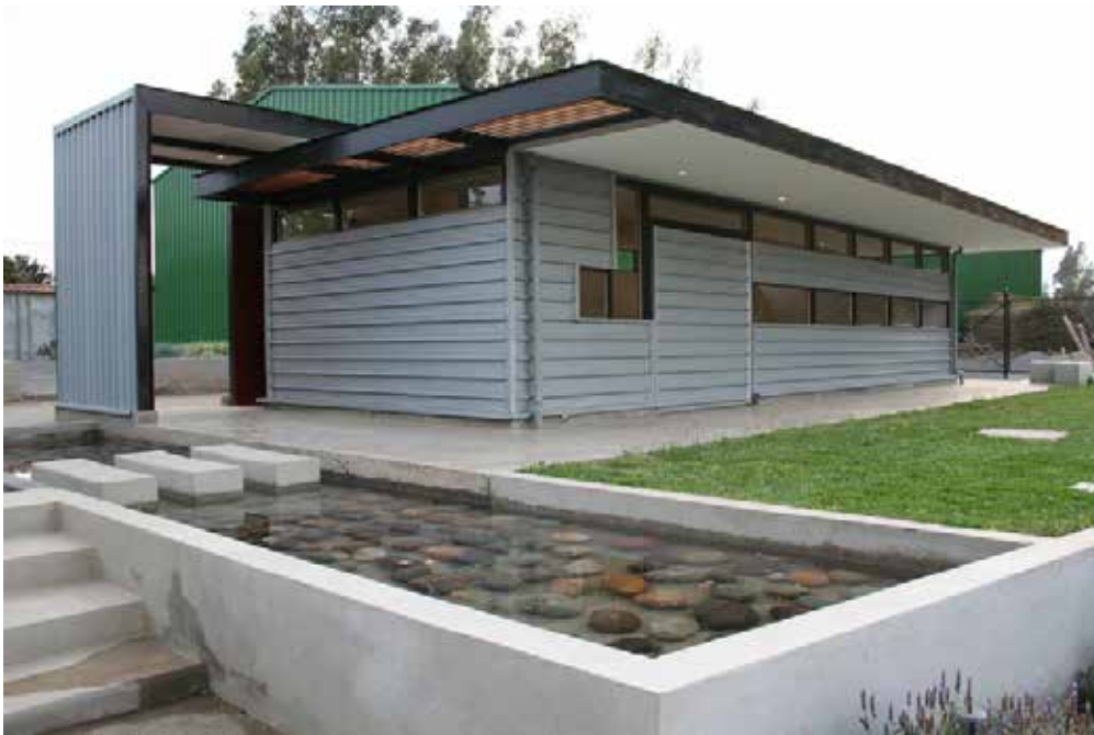
Figura 7: Comedor para Trabajadores. Mostazal, Chile. Fuente: http://en.wikiarquitectura.com (2009)
