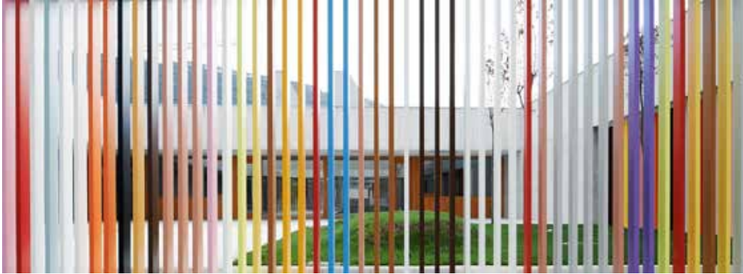
Figura n° 42. Tubos de colores en la fachada. Fuente: El autor. Año: 2017
