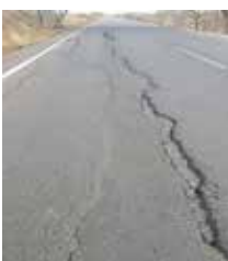
Foto 21/PROG. 23+050 HUNDIMIENTO
