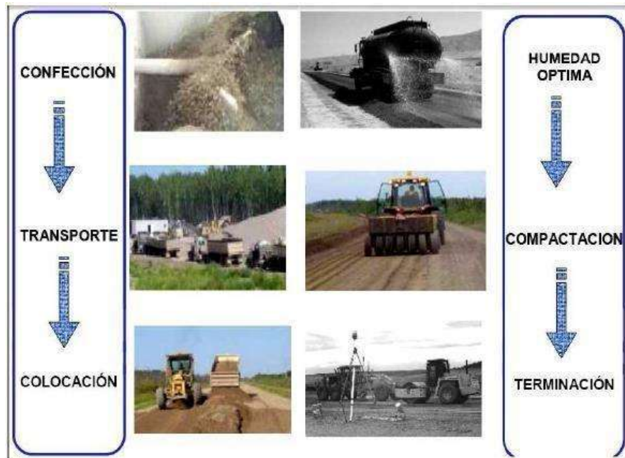
Figura 20. Etapas para la preparación de la Base
