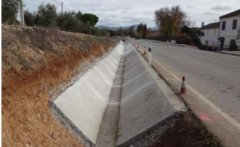
Figura 36. Drenaje Longitudinal de Vía
