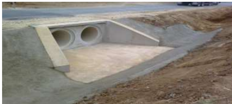
Figura 35. Drenaje Transversal de Vía
