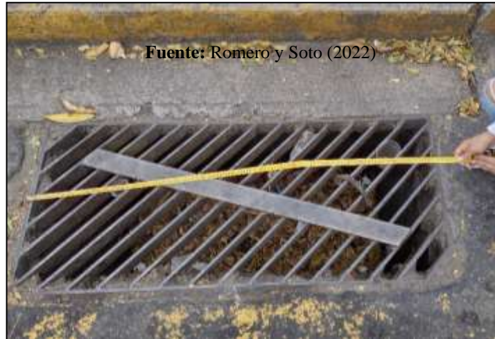
Sumidero de rejilla, calle Rondón
