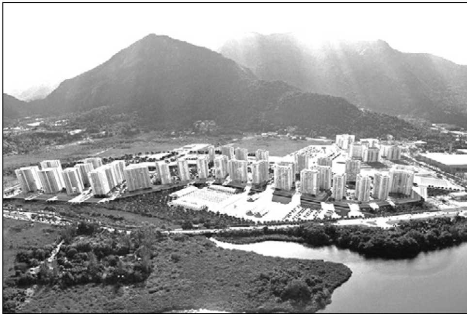
Figura 1: Villa Olímpica Rio. Fuente: http://www.brasil2016.gov.br/es/olimpiadas/instalaciones/vila-olimpica .(2016)
