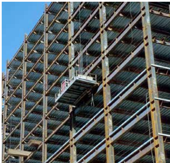
Fig. 6. Sistema de Pórticos Sismorresistentes
