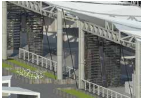
Figura 54: Columnas circulares en concreto (corredores laterales).
