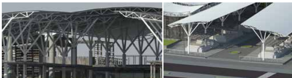
Figura 55: Columnas circulares metálicas arboladas (corredor central)
