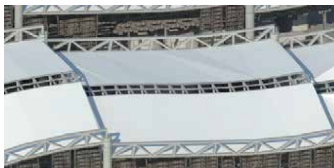
Figura 59: Vigas tipo cercha en corredores laterales.
