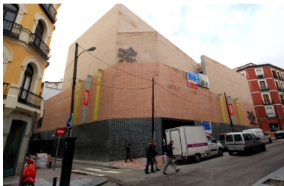
Figura 5: Fachada exterior de nuevo Mercado de San Antón, España.
