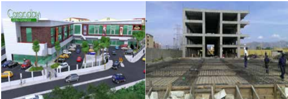
Figura 19: Digitalización de C.C Caranday (izq). Avance de obra de C.C Caranday (der).
