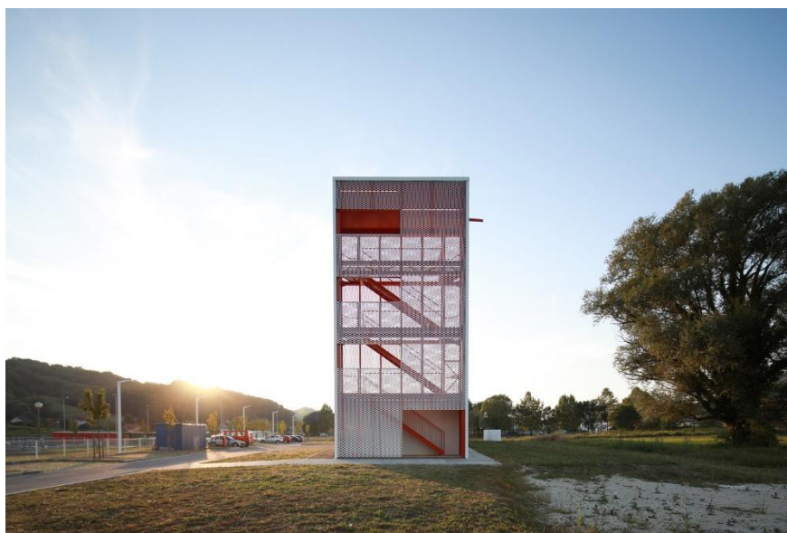
Figura 6. Centro de Protección Ambiental. Fuente: MVA (2022)
