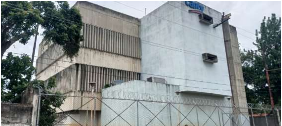
Figura 38: Vista del frente de la Central “Valencia Sur” (CANTV).
