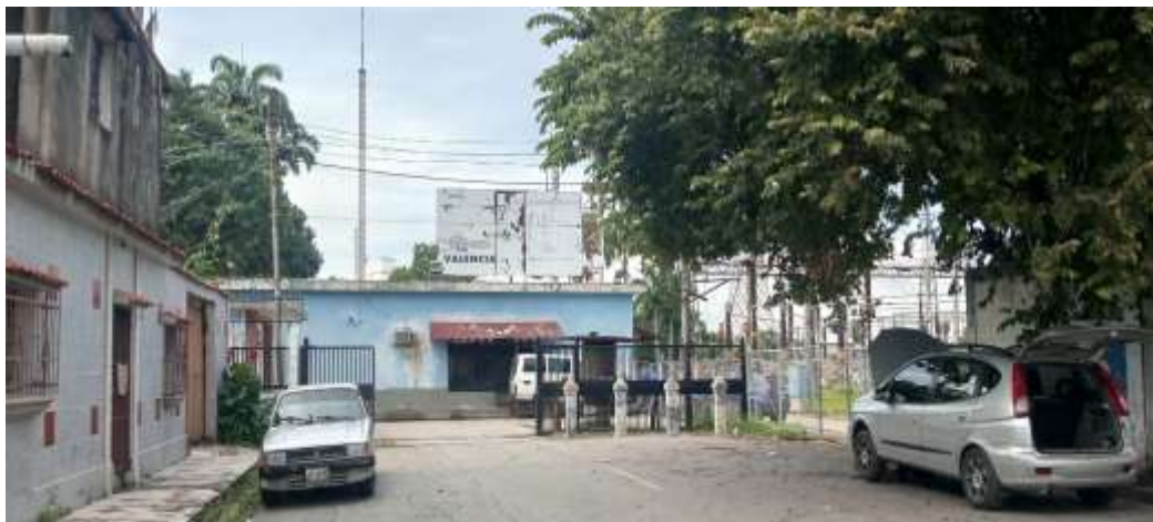
Figura 30: Vista del frente de la Subestación “GT2 Valencia”. Fuente: Obed Torrealba 2022.
