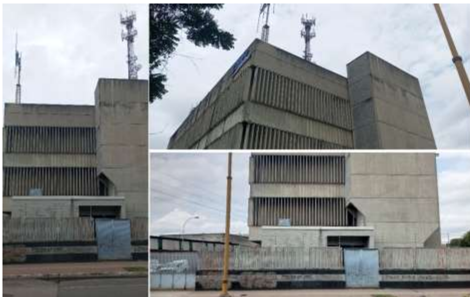
Figura 34: Vista del frente de la Central “La Fundación” (CANTV). Fuente: Obed Torrealba 2022.
