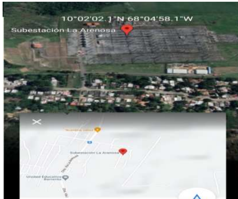
Figura 25: Vista Satelital de la Subestación “La Arenosa”. (CORPOELEC)
