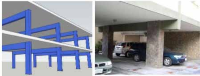
Figura 16. Ausencia de vigas altas. Fuente: Informe técnico FUNVISIS 2014.
