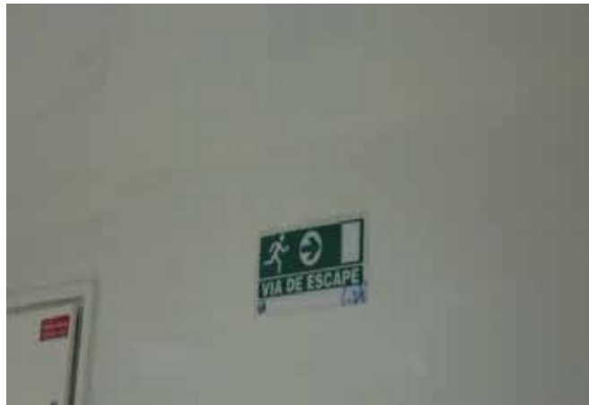
Figura 29. Señalización de rutas de escape. Fuente: Carly Dávila, Alexandra Rosero 2018.
