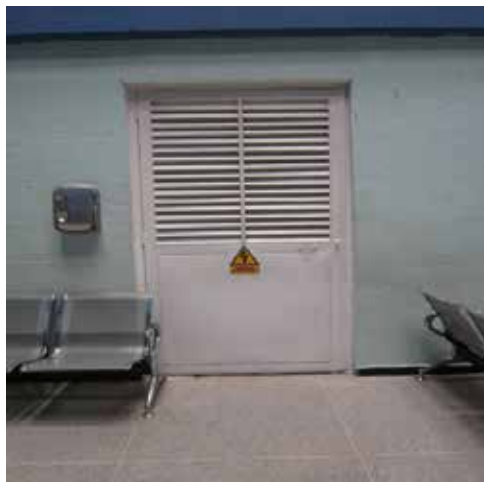
Figura 34. Tablero de control.
