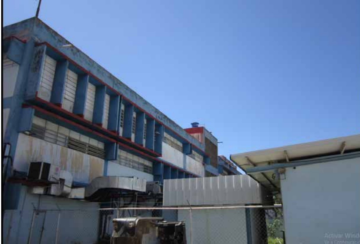
Anexo 6. Vista de Fachada posterior.
