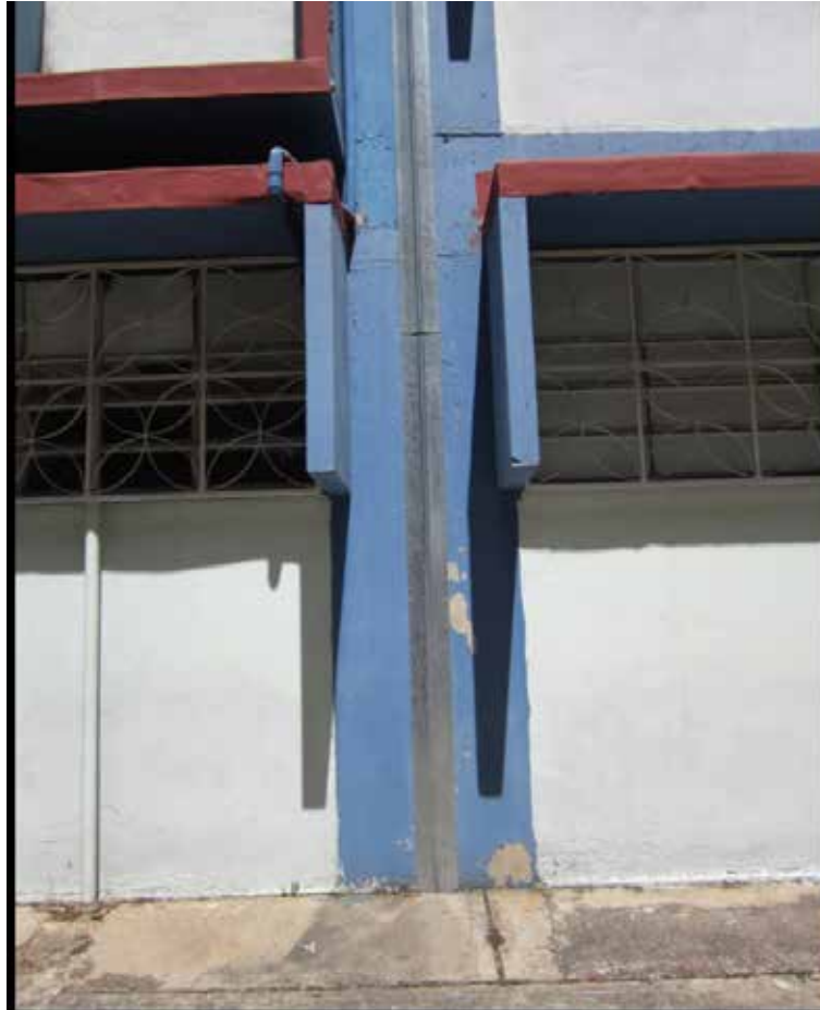
Anexo 37. Fotografía de Detalle de Columna Corta
