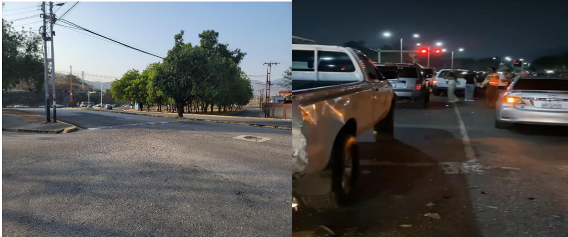
Figura 24: Iluminación en la intersección.
