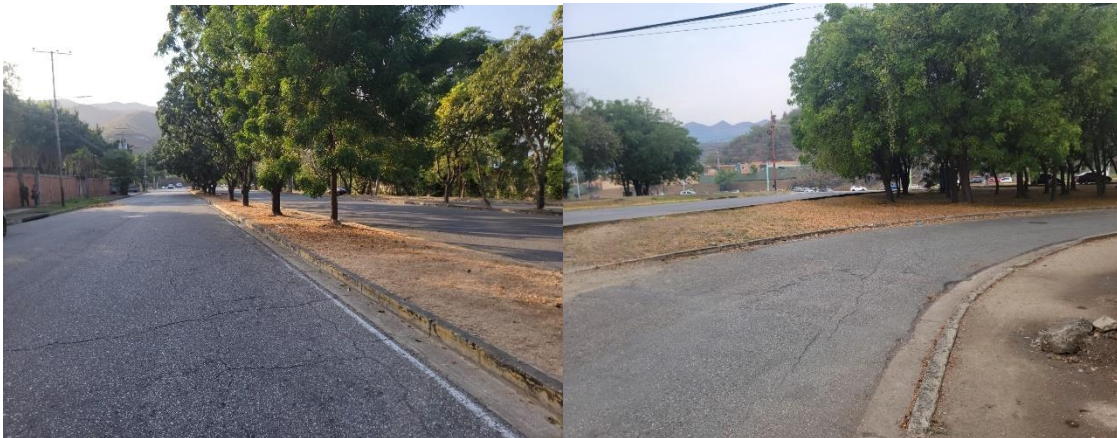
Figura 16: Grietas de contracción.
