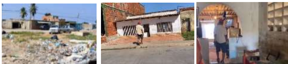
Figura 4. Condiciones actuales de las viviendas informales Santa Rosa, Playa Mansa.
