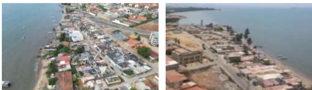
Figura 3. Vista aérea de las viviendas informales Santa Rosa, Playa Mansa.
