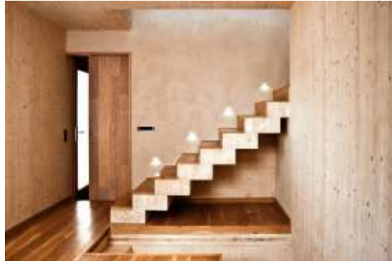
Figura 29. Paredes interiores con Mortero de arcilla ECOCLAY
