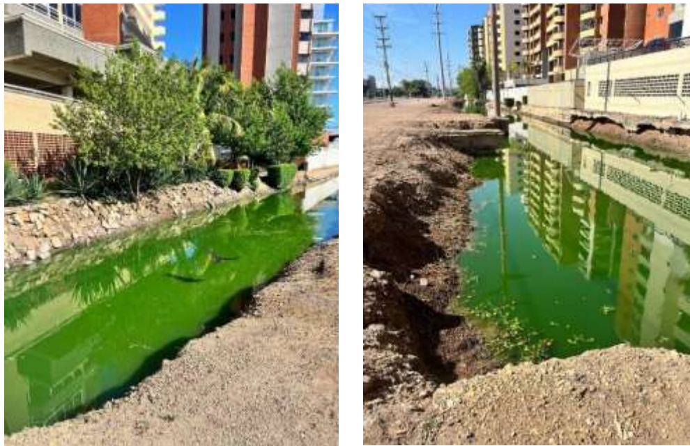
Figura 12. Situación actual canales de drenaje Av. Daniel Camejo Octavio
