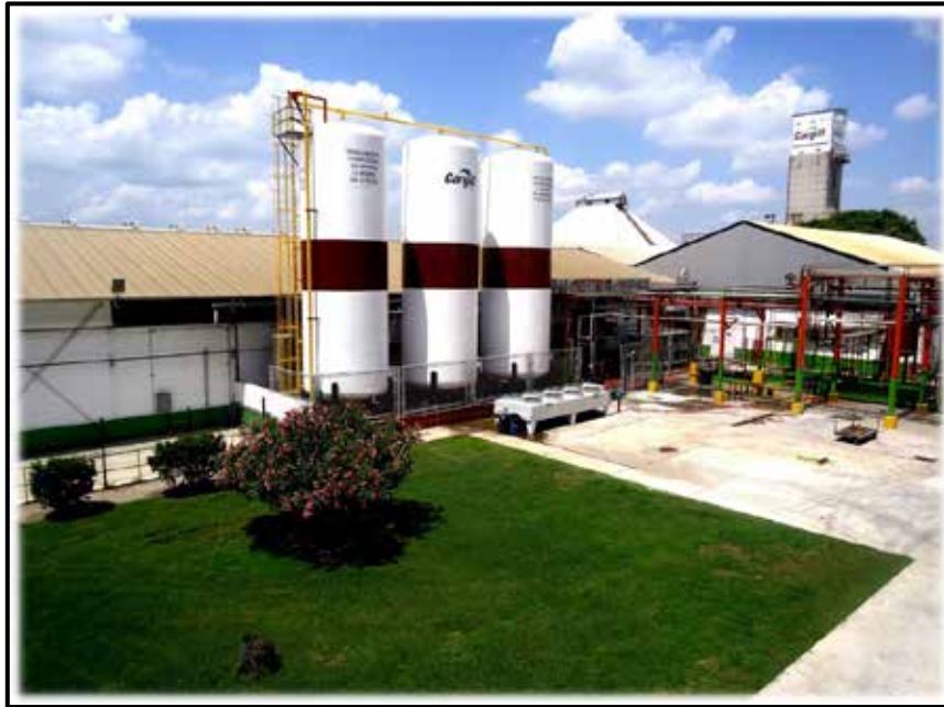
Figura 1. Planta Valencia, Cargill de Venezuela, S.R.L. Fuente: Portal Oficial, Cargill.
