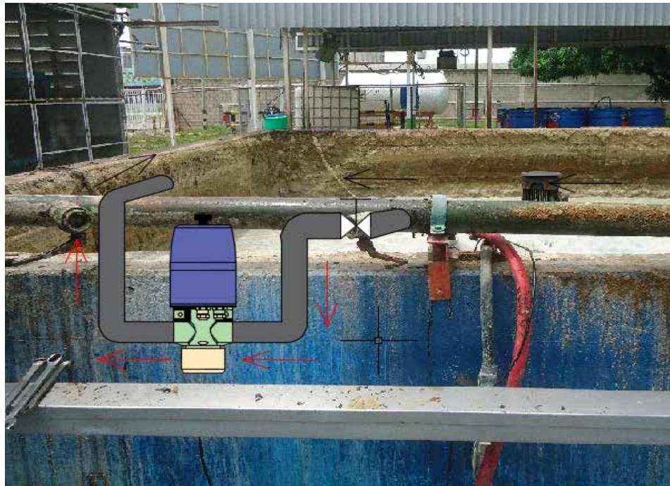
Figura 28: propuesta ilustrada de instalación con salida abierta en la salida del tanque de igualación TK-10001. Fuente: Realizado por el autor(2019)
