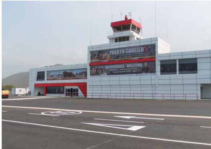
Figura 12: Aeropuerto Bartolomé Salom, Municipio Puerto Cabello. Fuente: http://prueba.mpptaa.gob.ve/?q=node/813
