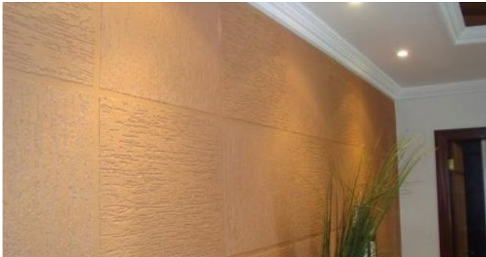
Figura 27: Pared Friso Grafiado. (2017)
