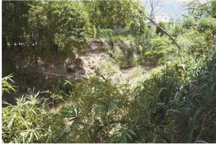
Figura 3: Puente sector Bomba Mobil (11/10/2016)
