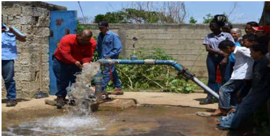
Figura N°12: Pozo profundo en sector Dios todo poderoso de Aragiita.
