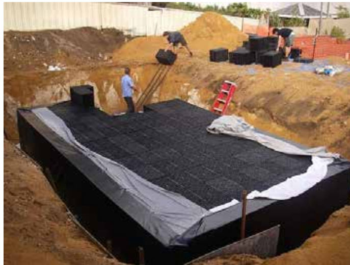
Figura N°34: Tanque modular enterrado
