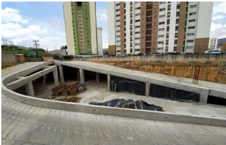
Figura 39. Vista en directo del Portón de Acceso #6 Fuente: Romero, D (2020)
