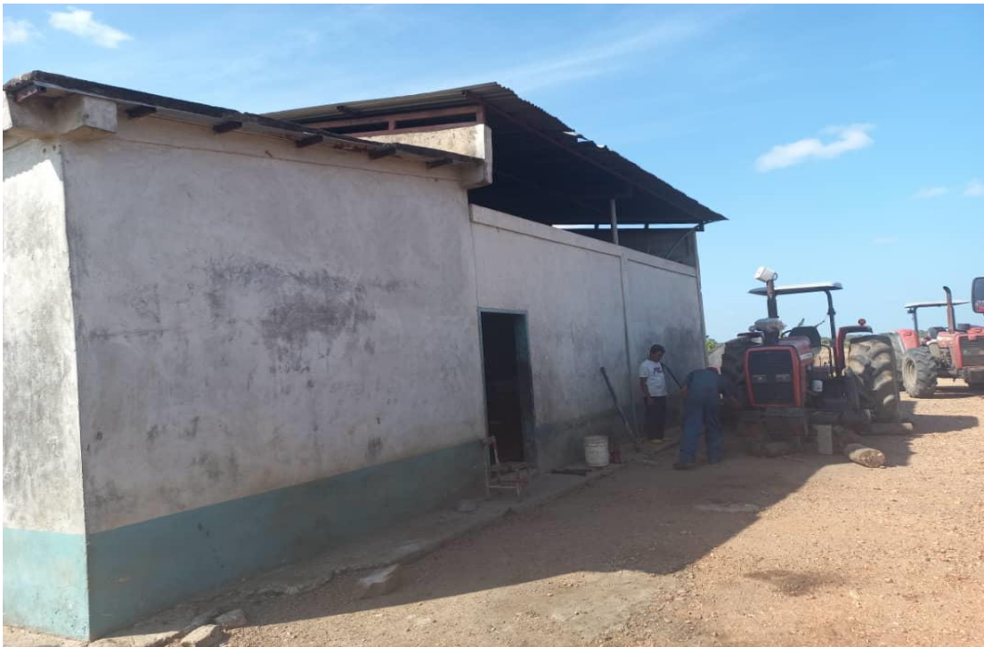
Figura 13 Vivienda ubicada en la parcela 566
