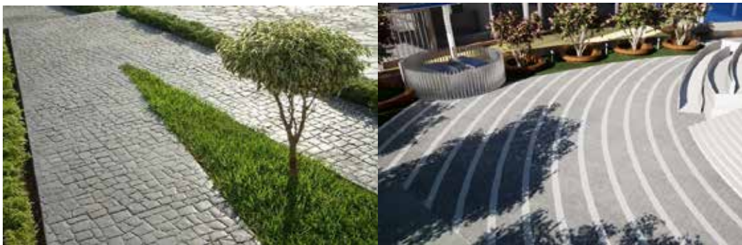
Figura 57. A la izquierda, vista real del concreto estampado. A la derecha, vista del concreto estampado en la plaza de la Mediateca de Valencia (La Autora 2020)
