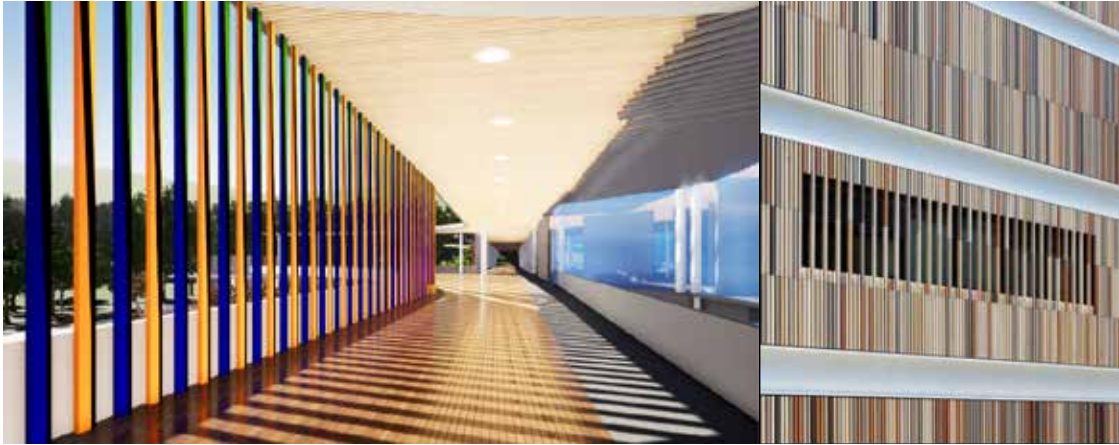
Figura 39. A la izquierda, zona del puente previa al acceso de la biblioteca desde el mismo, con formatos de baguette como parasoles en fachada este, La Autora (2020). A la derecha, una muestra del formato baguette NBK. (Manual Terracot NBK Hunter Douglas).
