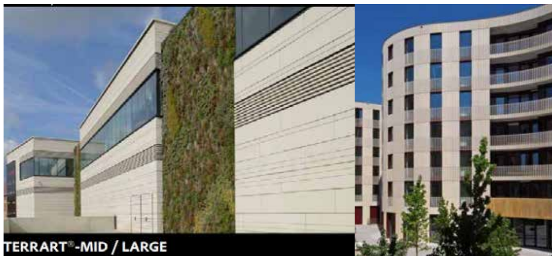
Figura 34. Muestra de paneles NBK en color blanco, formato medio y largo, en superficies curvas y planas. (Manual Terracot NBK Hunter Douglas).
