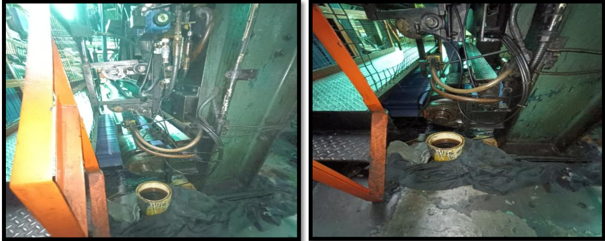
Figura 2. Fuga de aceite y trapos impregnados de aceite.
