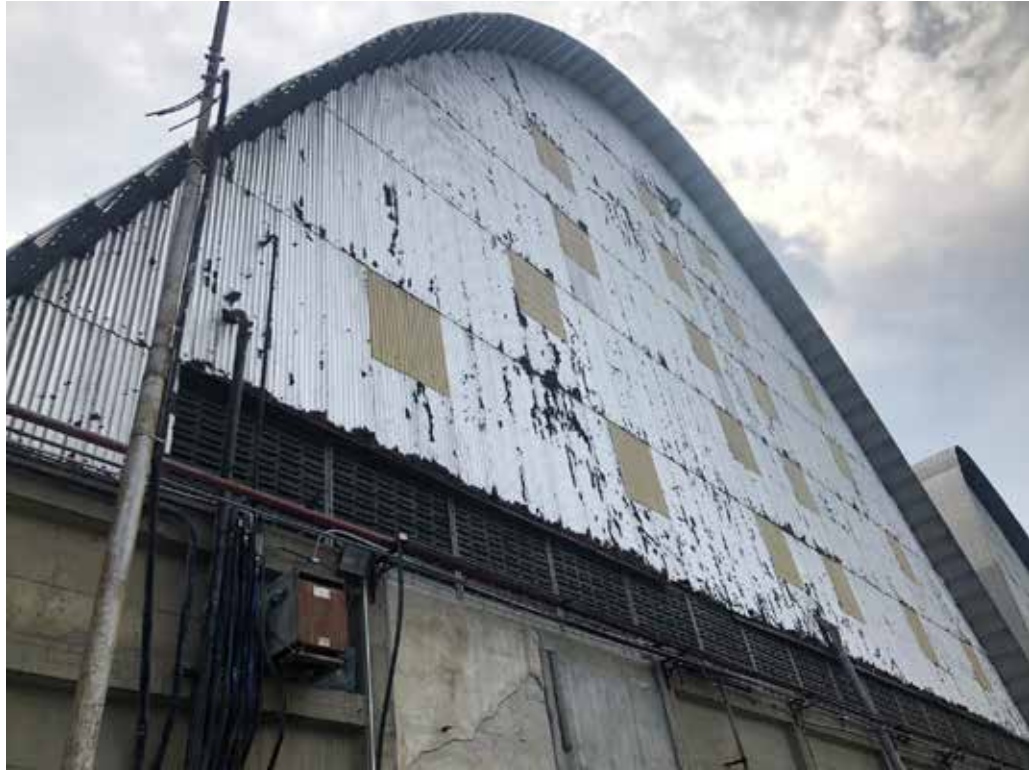
Anexo 1. Techo del Almacén Fuente: Aquino, E. (2019)
