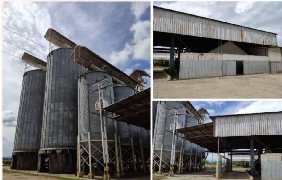
Figura 1: Vista frontal de las instalaciones.
