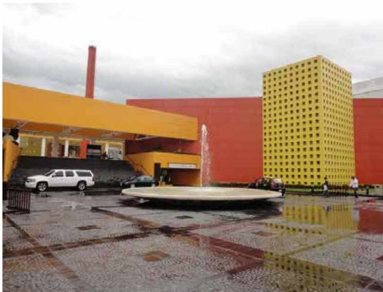
Figura 3. Vista de fachada - Centro de Convenciones Puebla.
