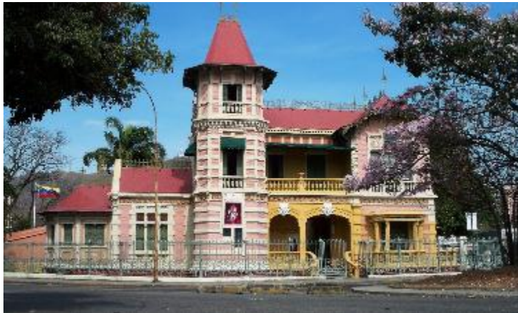
Figura 12: Quinta “La Isabela” ubicada entre la intersección de las Avenidas Miranda y Rojas Queipo en la ciudad de Valencia.
