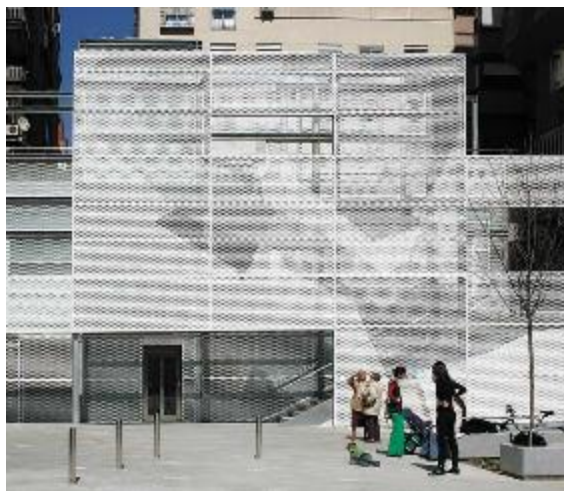
Figura 14: Sistema de Fachada de chapa metálica perforada.
