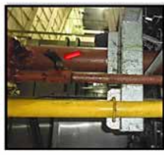
9.1.2.12 Abrir la llave del filtro que permite el paso de aceite hacia el tanque de recuperación
