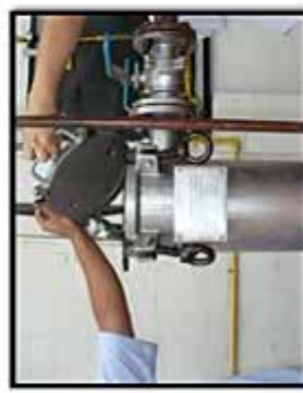
9.1.1.9 Reemplazar malla del filtro por una nueva.
