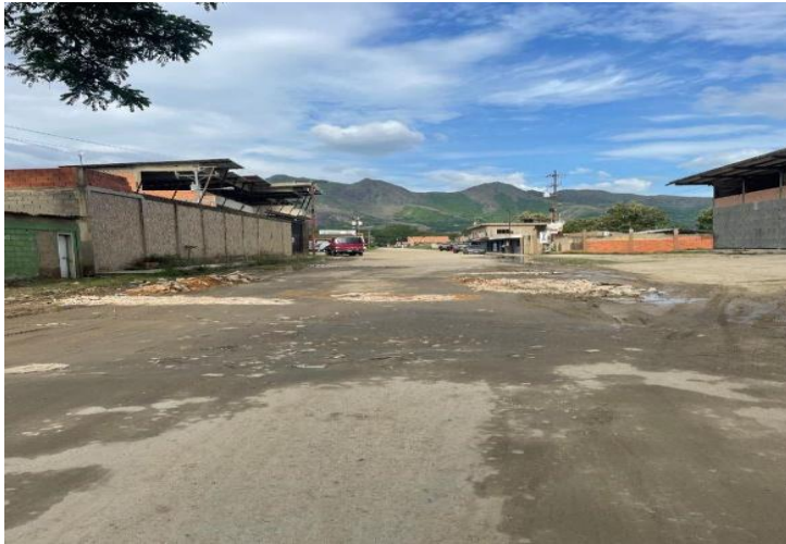
Figura 31. Ausencia de Demarcación e Iluminación
