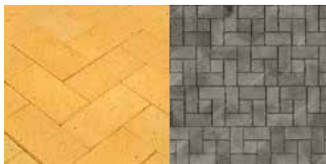
Figura 64. Pavimento de Adoquín de Hormigón amarillo y gris. (2018).
