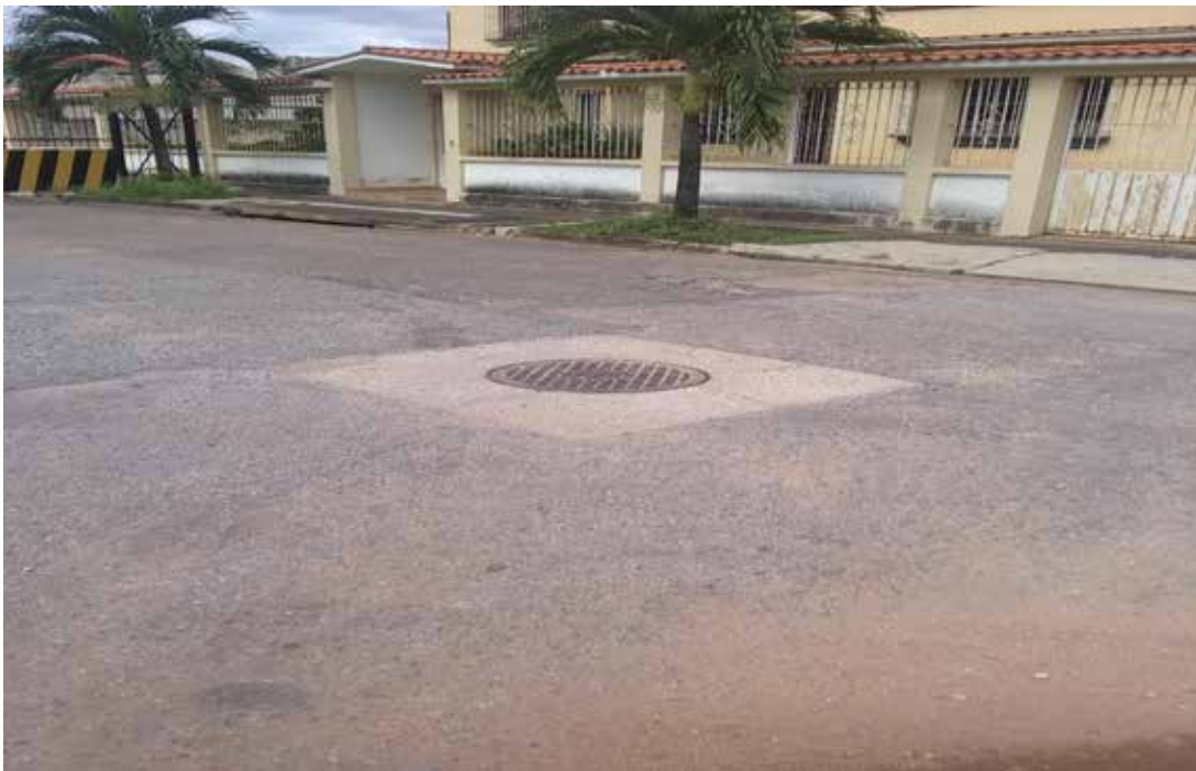
Figura 58. Vista de calle 124 esq. Av. 108. Alcantarilla de aguas negras.
