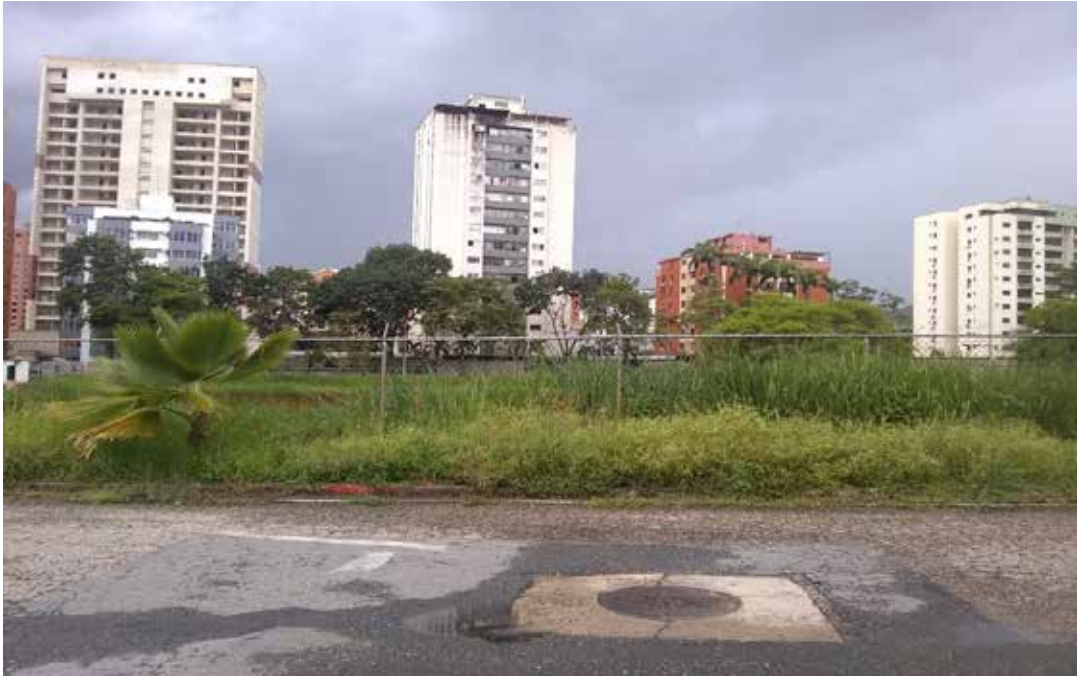
Figura 57. Vista de calle 124 Alcantarilla de aguas negras.
