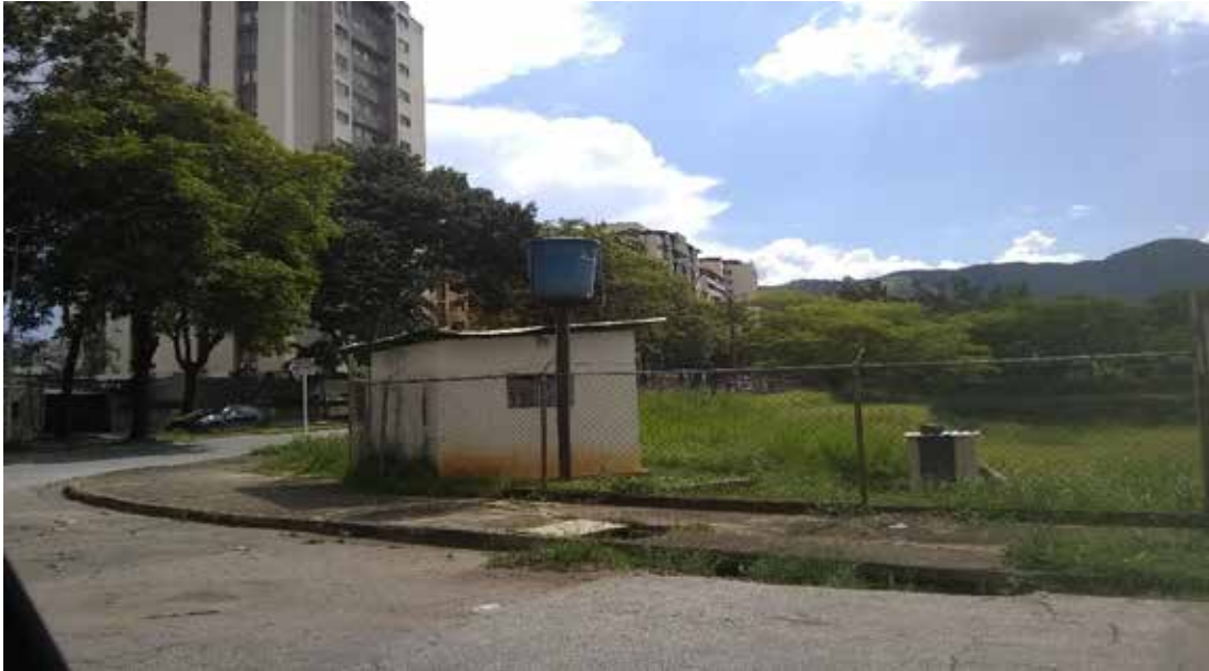
Figura 55. Vista de av. 108 tanquillas de recolección de aguas pluviales.
