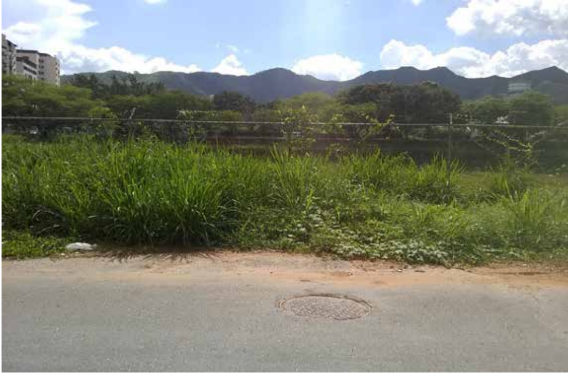
Figura 59. Vista de Av.108. Alcantarilla de aguas negras.
