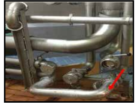
Imagen # 30. tuberías ICE vaciado
