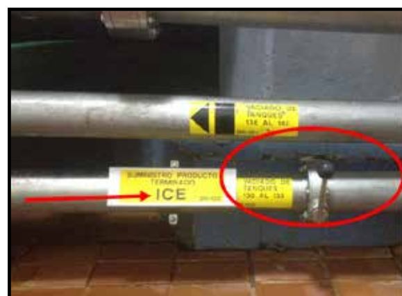
Imagen #3. Válvula de choque
