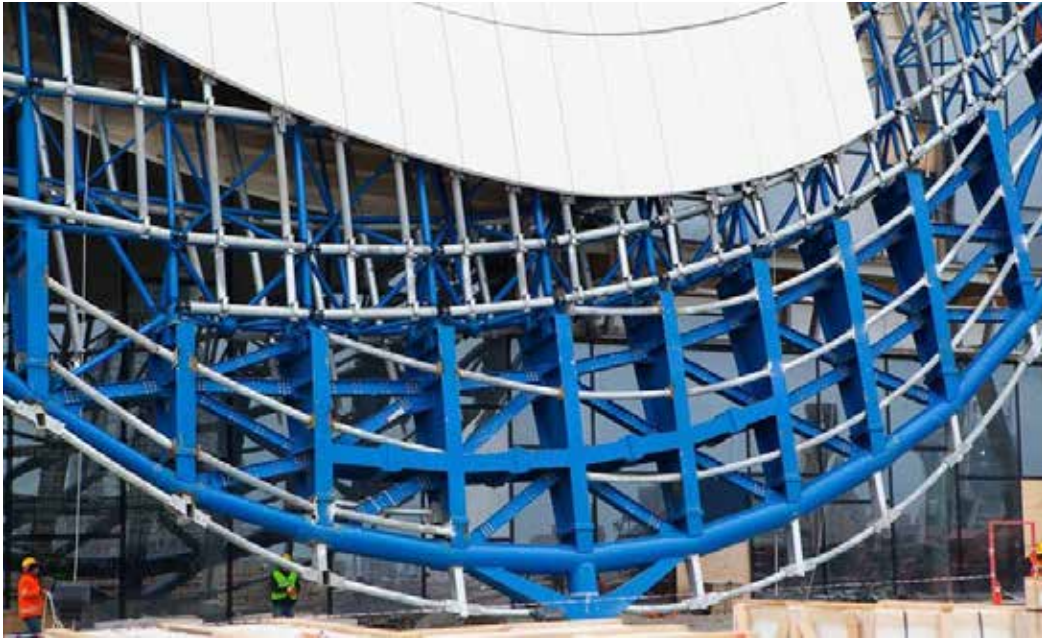
Figura 37. Estructura de malla espacial, Centro Heydar Aliyev, Zaha Hadid.
