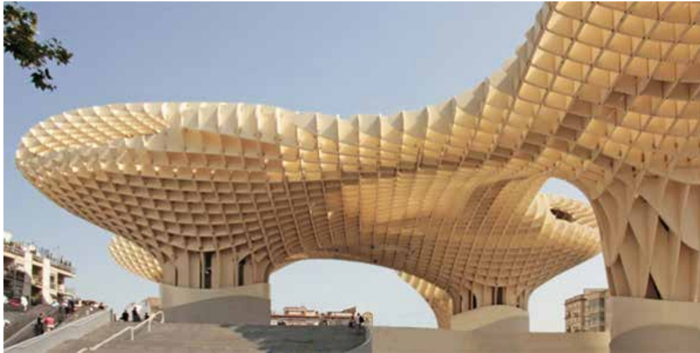
Figura 38. Estructura Waffle. Metropol Parasol Sevilla.
