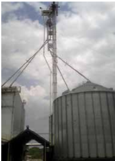
Foto del área de recepción y transferencia.
