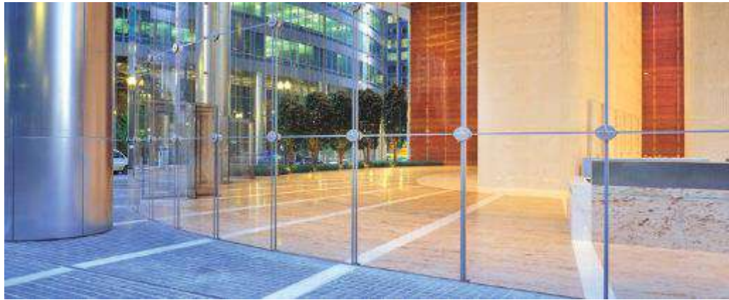
Figura 20: Paneles de vidrio antireflectante. Fuente: Amiran (2019)
