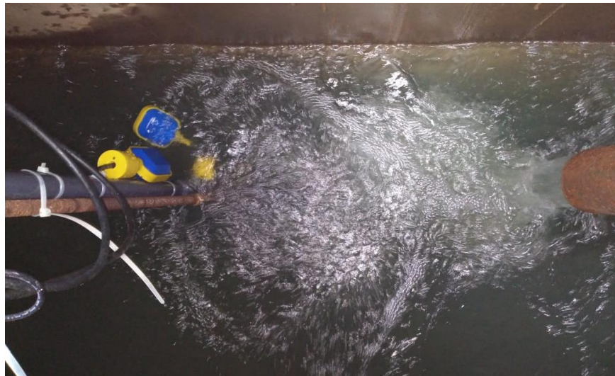
Figura 32. Sensores instalados en el tanque de agua helada
