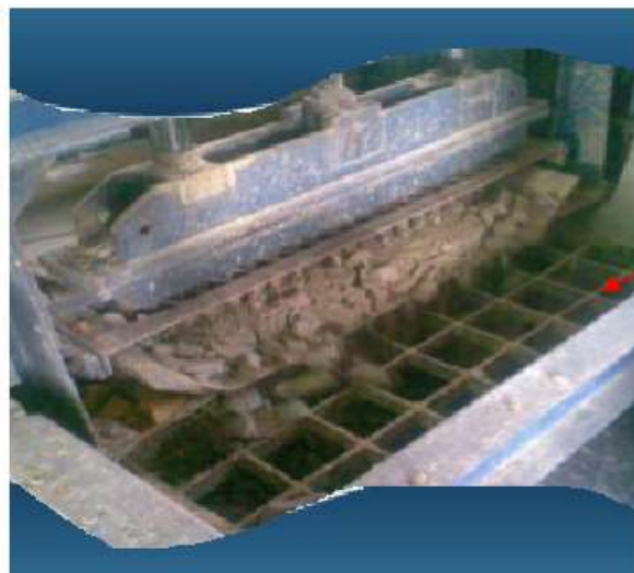
Figura 27: Rejilla metálica. Fuente: AMV. C.A. (2019).
