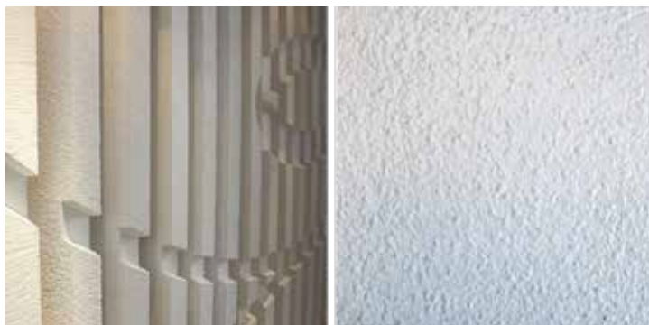
Figura 58. Acabado en Concreto Martelinado.
