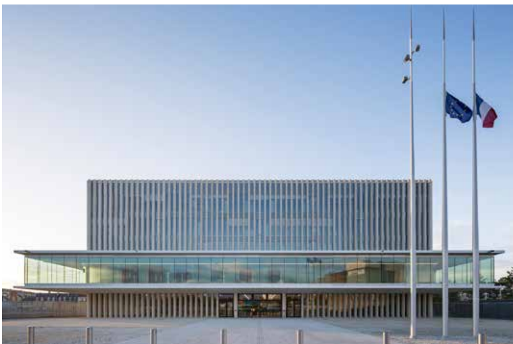
Fachada principal donde se demuestra la calidez del volumen. Fuente:
