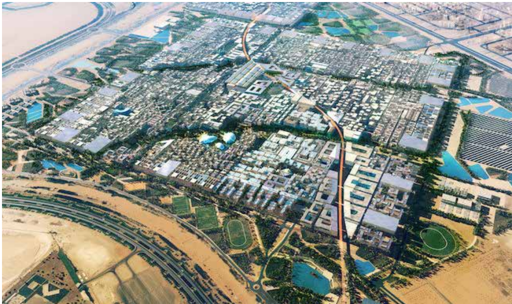
Complejo de edificios Masdar Abu Dhabi - Emiratos Árabes
