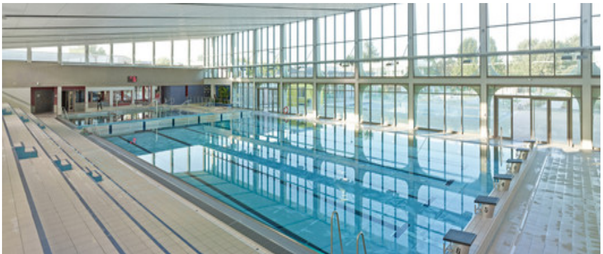
Figura 3. Centro Acuático Montigny-les-Metz. Fuente: www. Plataforma Arquitectura.com (2014).
