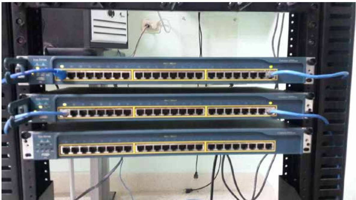
Figura 1: Conectividad Fisca de los Switch Catalyst 2950
