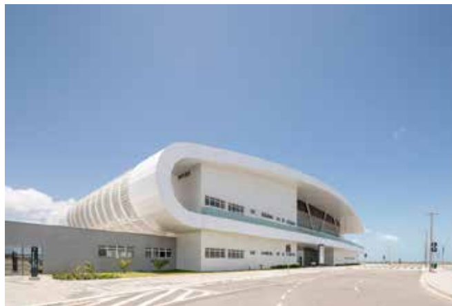
Figura 3. Fachada Principal. https://www.plataformaarquitectura.cl/cl/785736/terminal-maritimo-de-pasajeros-terminal-fortaleza-architectus-s-s (2016).
