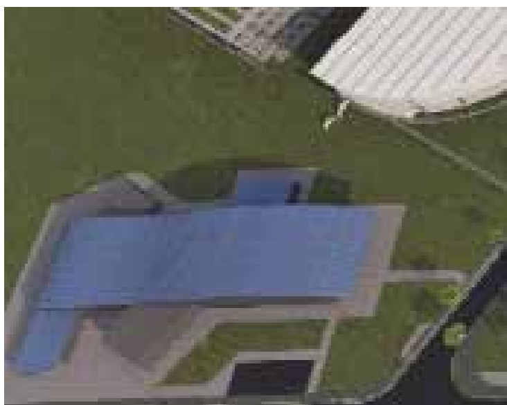
Figura29. Vista en planta de la Planta de Tratamiento de Residuos Orgánicos y Residuales (2017)
