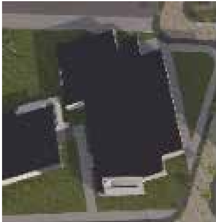
Figura30. Vista en planta del Edificio Administrativo (2017)
